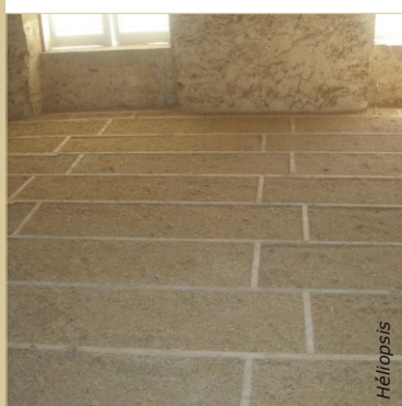
Un contre solivage a été mis en place dans ce grenier. Un plancher sera fixé dessus. La pièce pourra être utilisée en chambre d'été.
