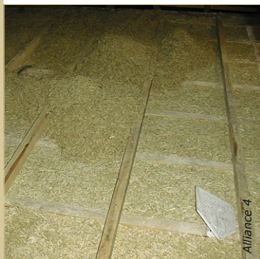
Le chanvre stabilisé est mis en place en deux couches de 15 cm rabattues par tassage à 10 cm. L'épaisseur conseillée de la régulation est de 20 cm.
