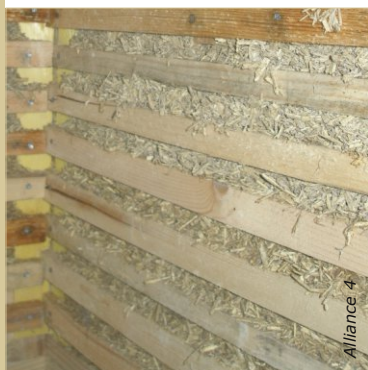
En remplissage d'un lattis, finition enduit terre ou chaux, le chanvre stabilisé est utilisé pour la construction de cloisons, doublages et murs pleins.
